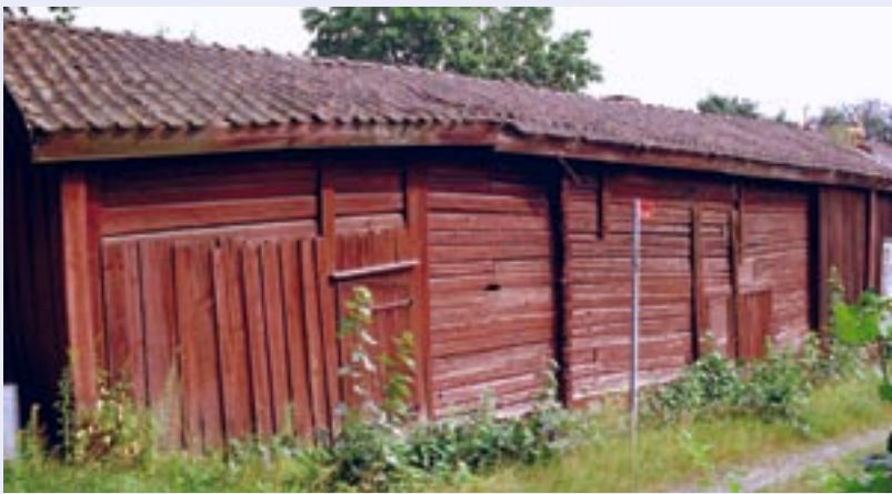
Låt inte huset förfalla! Rätta till takpannor som kommit på sned, byt de som är spräckta. Låt inte naturen ta över! Se till att marknivån inte blir för hög, och att buskar och träd inte står för nära
