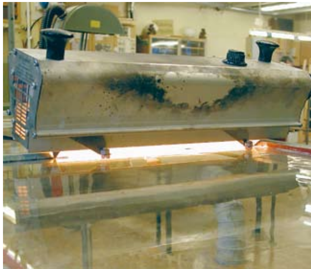
Bild: Demontering av kitt och glas med hjälp av kittlampa
