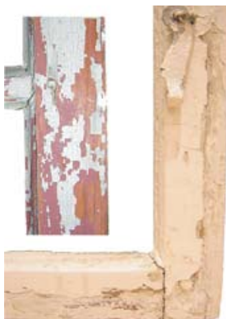
Ovan: Gammal finkracklerad linoljafärg med karaktäristiskt mönster. Till höger: Igensatt profil av tjocka lager lkydfärg.
